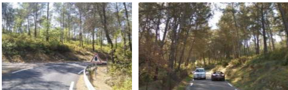
Profil sinueux et étroit de la RD57A en aval du site
