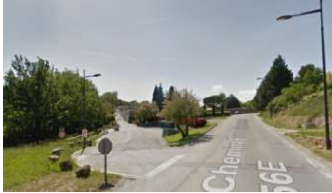
Connexion du chemin du Cros du Pont à la RD56E au niveau du cimetière
