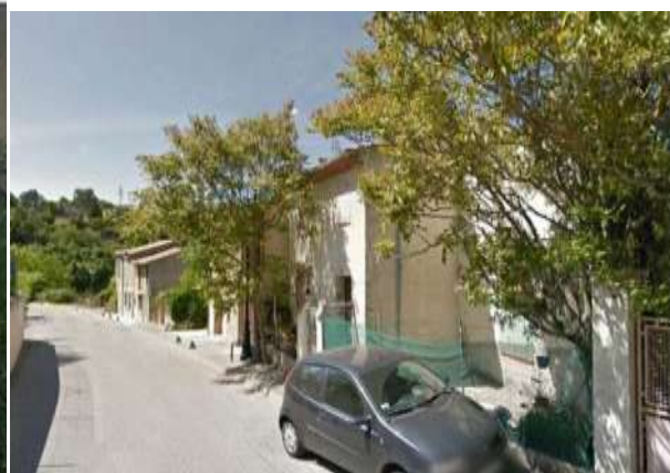
Alignement de maisons qu'il est proposé de sortir de la zone UC1 pour être intégré à la zone UA
