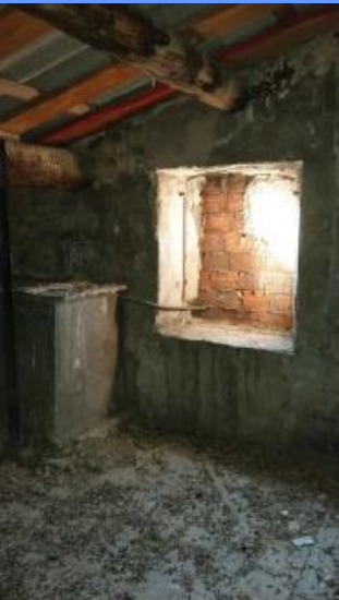
Vue 1 : Ouverture occultée au Sud
