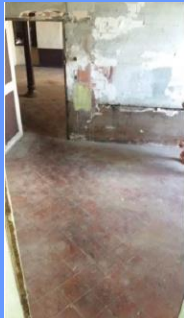
Vue 5 : Sol terre cuite
