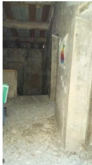
Vue 6 : Palier d'arrivée de l'escalier
