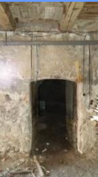
Vue 1 : Depuis l'ancienne étable
