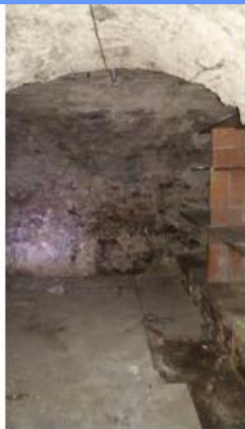
Vue 2 : Les caves voûtées
