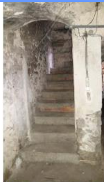
Vue 4 : Escalier d'accès au niveau du cours Escalier avec marche en pierre
