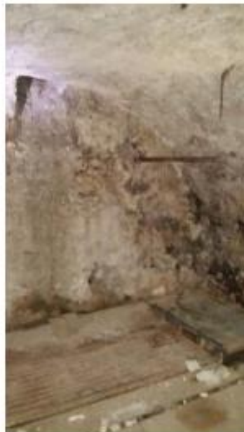
Vue 6 : Vue intérieure cave : Puits sous les planches
