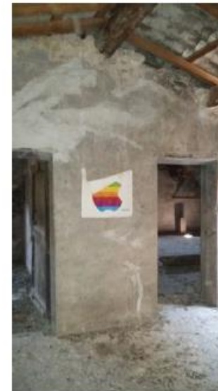
Vue 7 : Vue du palier sur les salles
